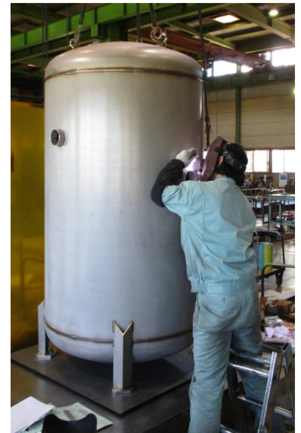
1,100Lタンク 溶接の様子
